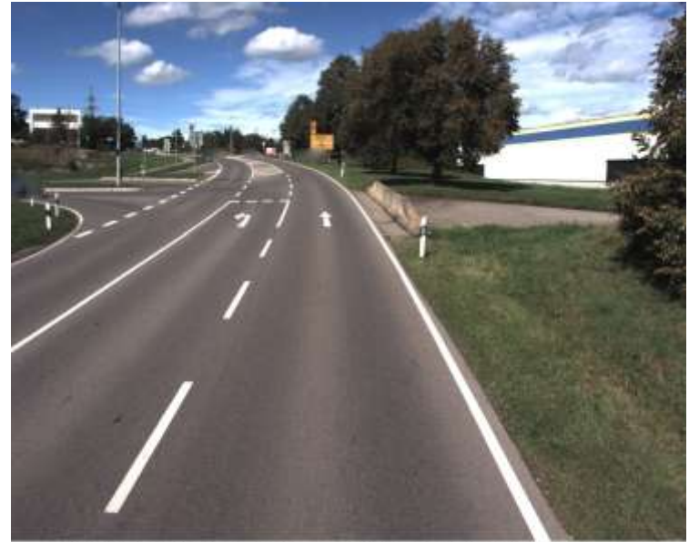
Straße: K7107, Abschnitt: 7619070 - 7619026, Station: 85, Lage: R, FS: 1
