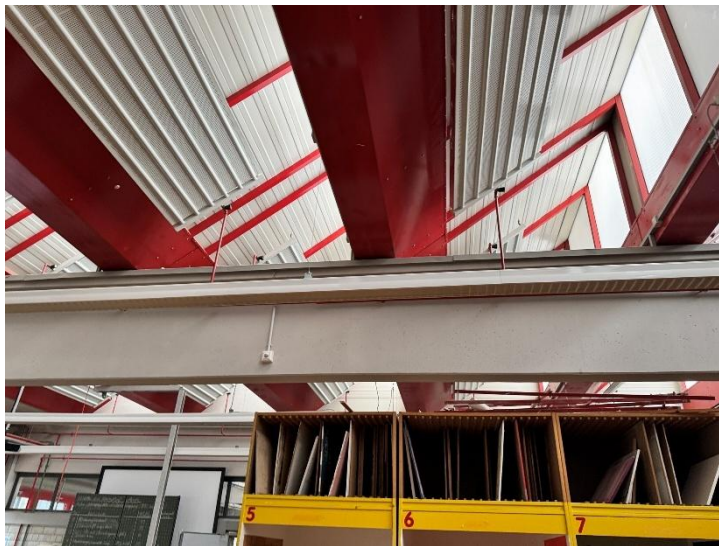
Innenansicht Sheddach Elemente
