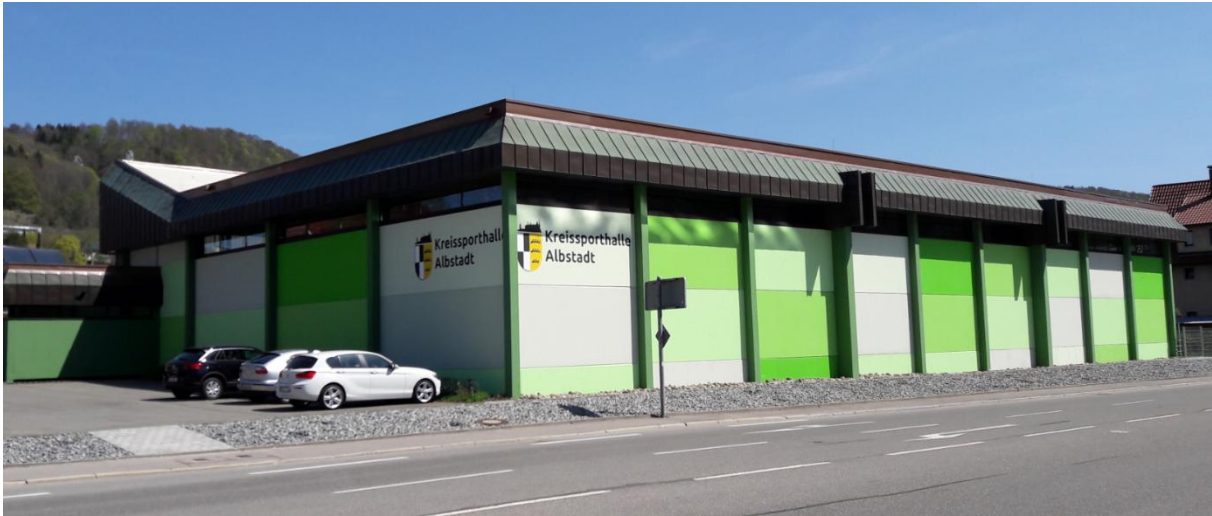
Abbildung 7 Kreissporthalle Albstadt, Südfassade
