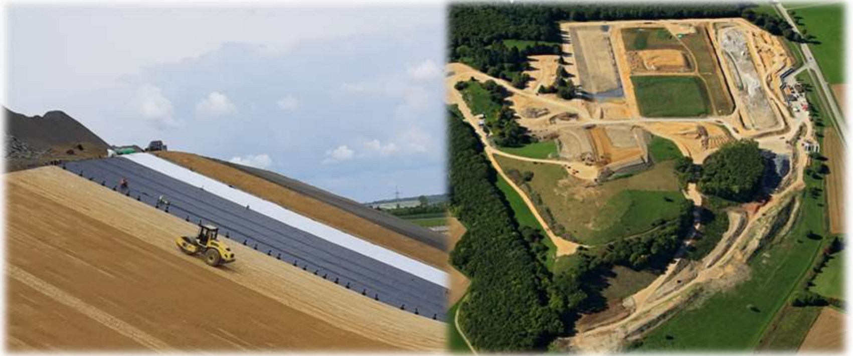
Ausbau DK 0 und DK I Deponien in Albstadt und Balingen - Basisabdichtung
